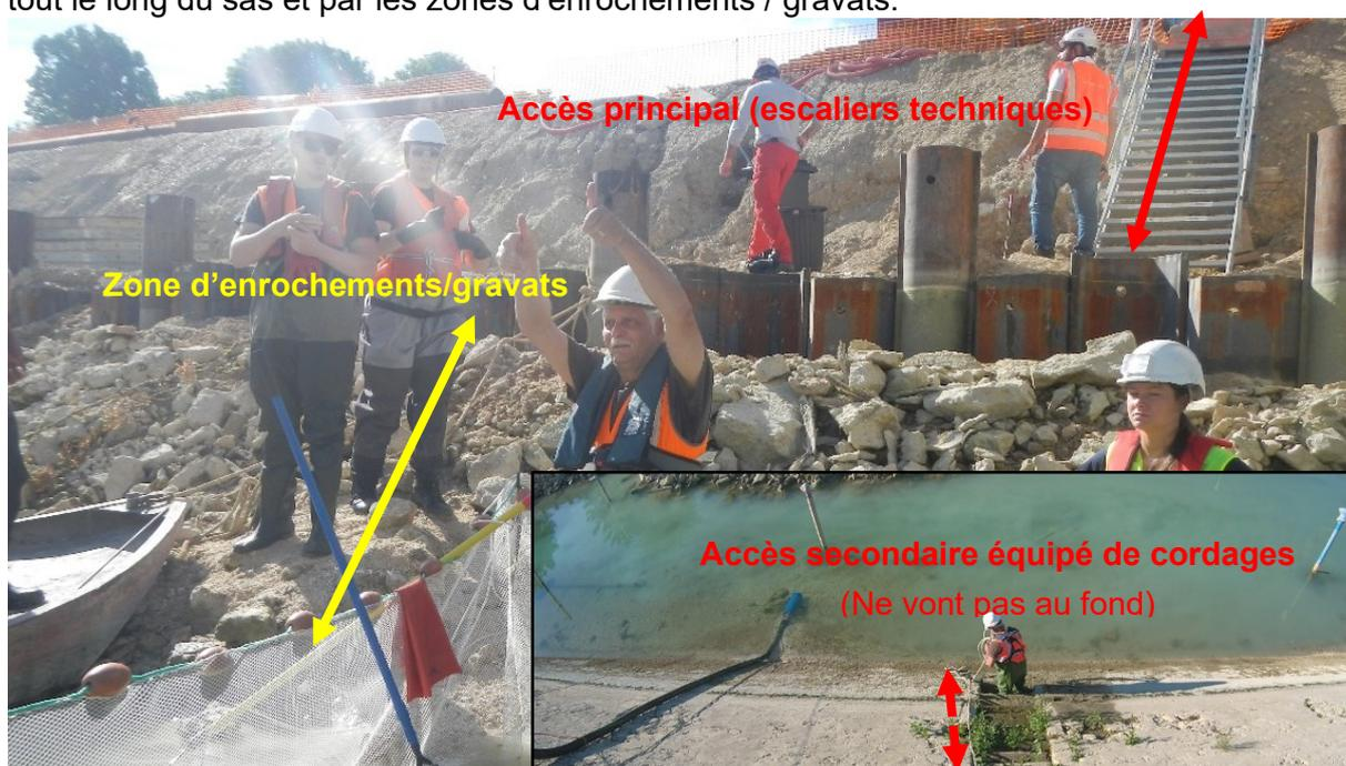
**Figure 6. Accès : accès principal rive gauche \_ accès secondaires rive droite(perré)**
