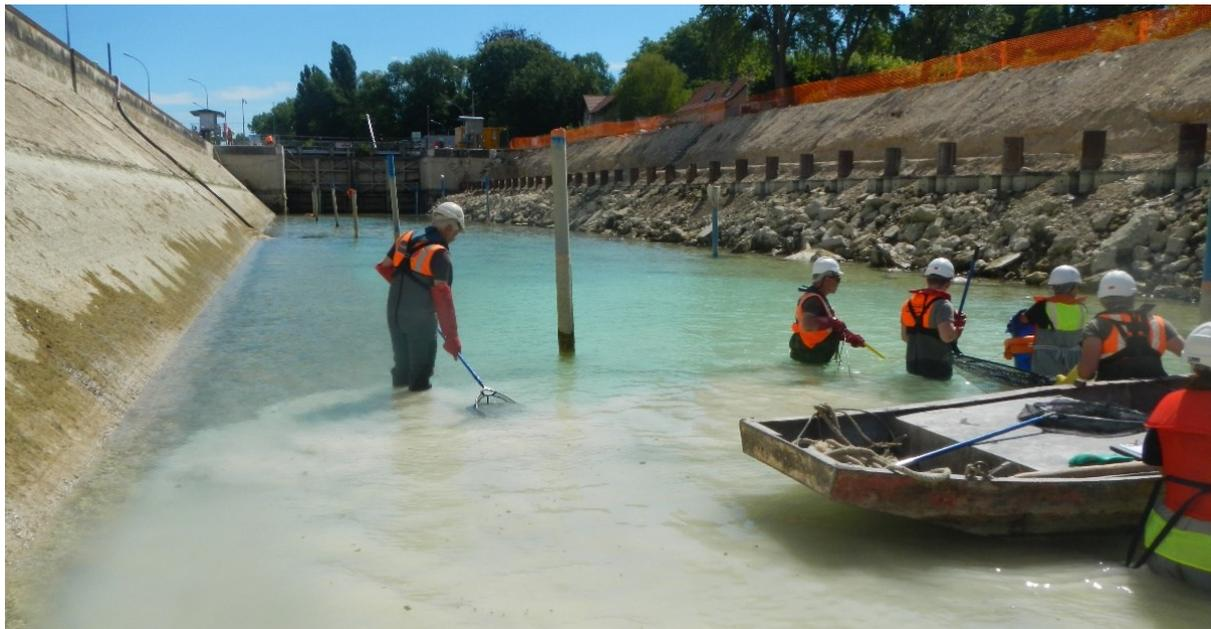
**Figure 10. Turbidité générée par les opérateurs rendant complexe la visibilité et la progression**
