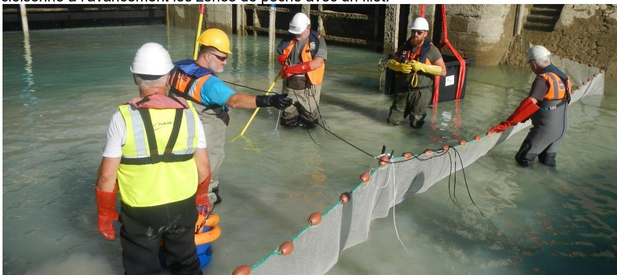
**Figure 16. Pose de filet pour confiner les différentes zones de pêche**
