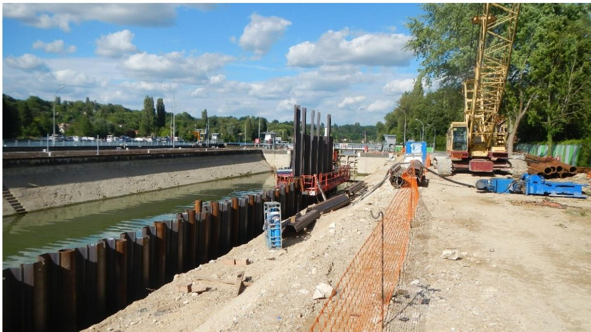
**Figure 7. Mise en place d'un rideau de palplanches et pieux**
